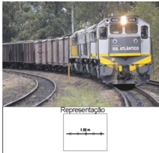
Fig. 2-8 – Ferrovia de linha múltipla (Ferrovia Sul Atlântico)
